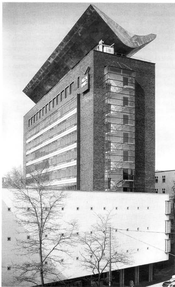
Figure 12 - 13. L'edificio per uffici degli anni Sessanta, a Francoforte sul Meno, prima e dopo l'intervento dell'architetto Christoph Mäckler, realizzato all'inizio degli anni Novanta.
